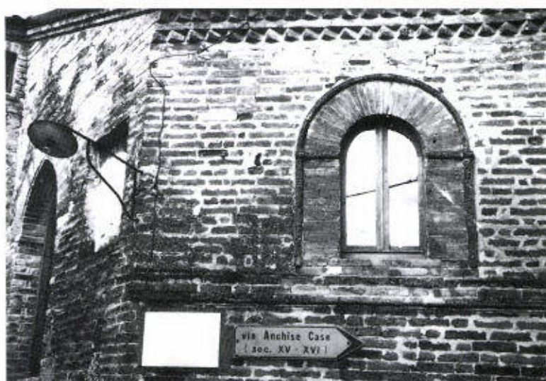
Particolare di una casa
