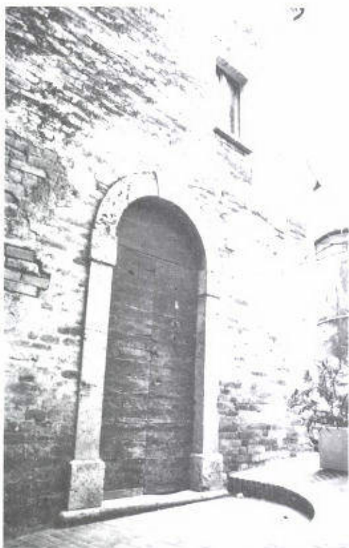
Una tipica porta delle case in laterizi del castello di Ripaberarda
